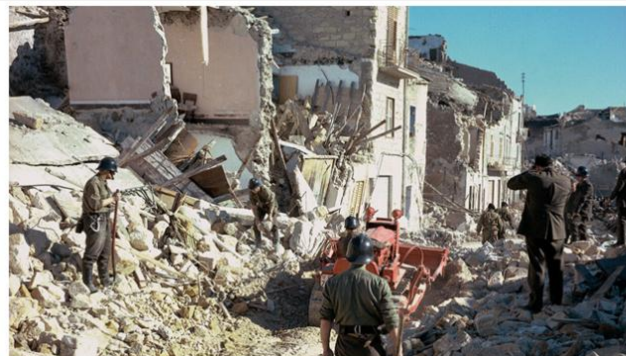
Una foto scattata dai vigili del fuoco nei luoghi del sisma
