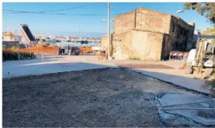
Pista. Lavori di sistemazione della condotta fognaria a Sciacca. (Foto: Massimo)
