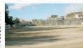
Cominciati gli abbattimenti degli alberi della villa comunale. In alto: il cantiere di ammodernamento dello stadio "Bordonaro". In basso: un'immagine aerea della villa comunale.
